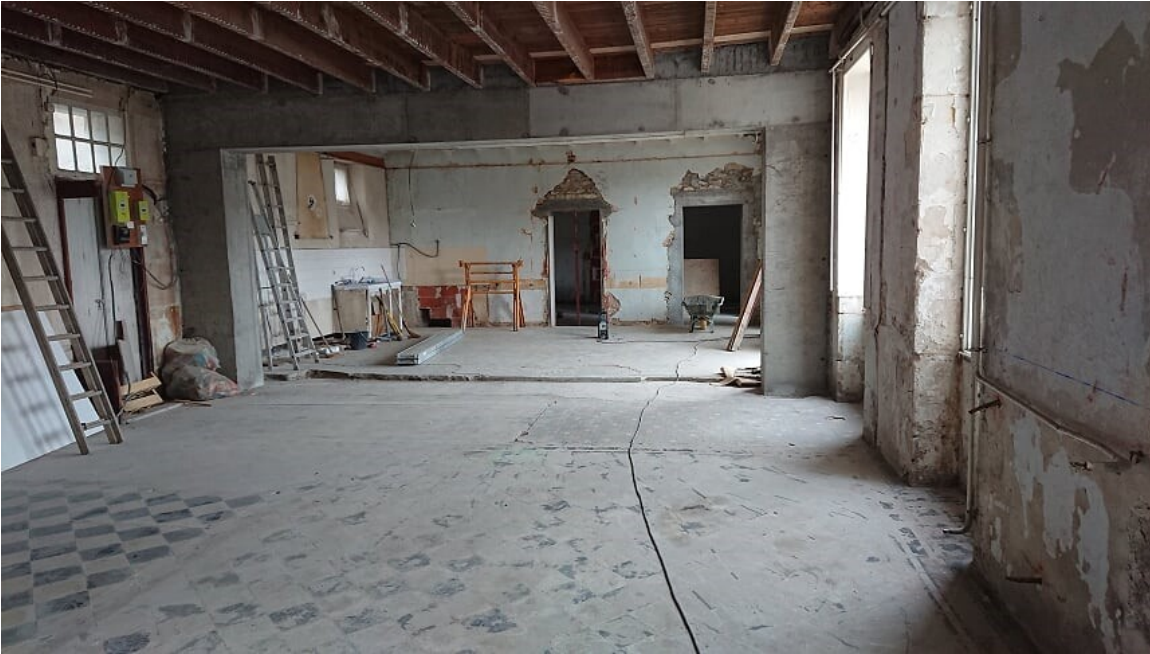
La Maison des Sœurs avant les travaux.
